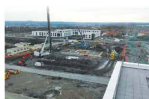
*D'un diamètre de 50-60 cm, les pieux sont battus sur une profondeur de 24 à 30 m.*
