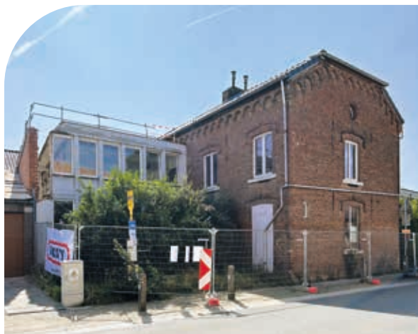
Les travaux commencent par la démolition de cette maison
