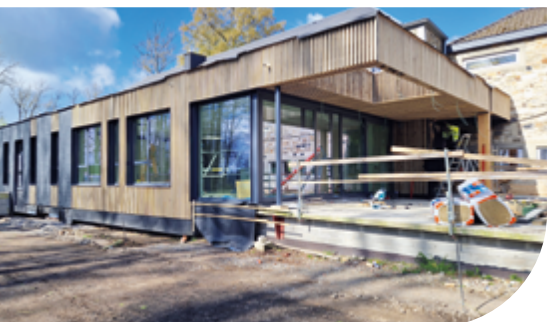
L'extension du restaurant courant avril. © AASA Architectes – Nicolas GERARD
